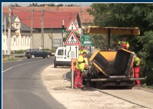
Épülnek a járdák
